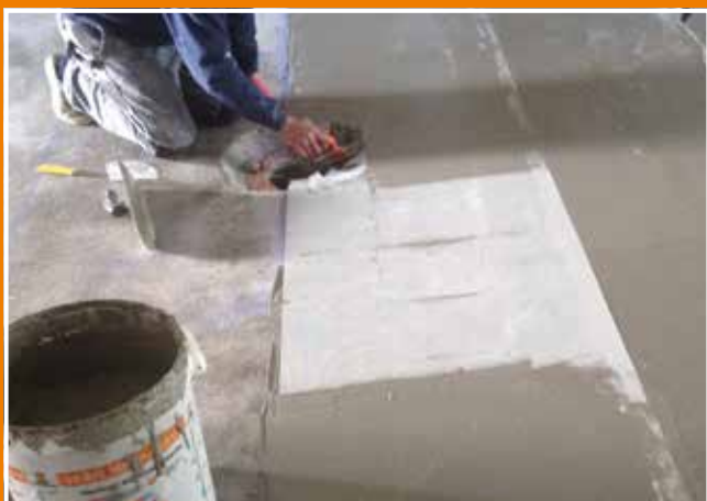
Pose du treillis ARMACEL en continu
