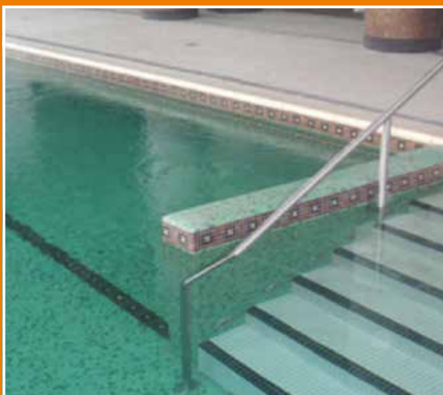
Étanchéité des bassins
