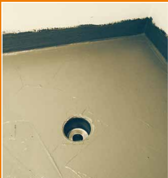
Étanchéité sur platine inox et "platine Nattes Céramic"
