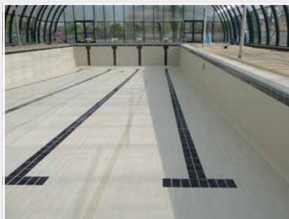
Étanchéité des bassins
