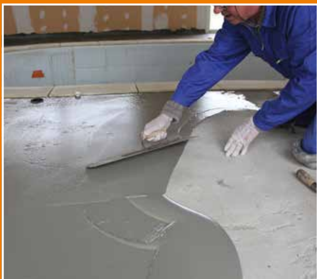
Application à la lisseuse ou peigne cranté V4/V6 mm
