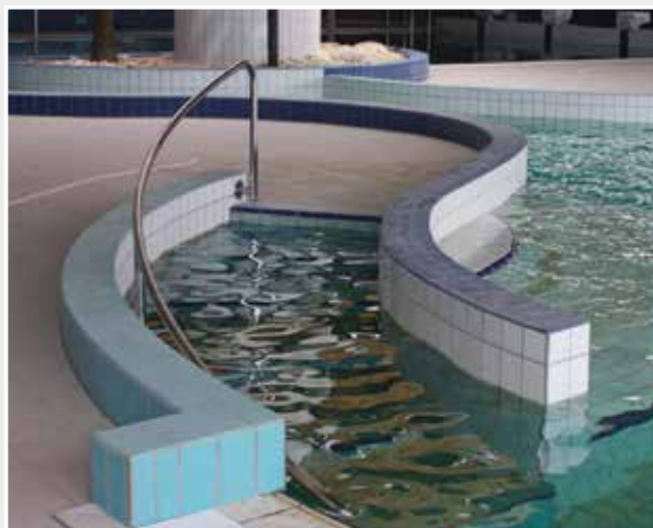
Étanchéité des bassins
