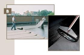
Les membranes d'étanchéité doivent être déroulées et alignées tout en veillant aux recouvrements de 10 cm qui resteront dépourvus de toute colle. Rabattre les bandes de moitié et libérer ainsi le support. Y étaler la DERBIBOND NT à l'aide d'une raclette dentelée d'étancheur DERBIGUM. Redéposer sans attendre les bandes dans la colle et répéter l'opération pour l'autre moitié.
