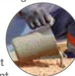
④ Assurer le blocage du 1<sup>er</sup> rang en coulant les joints verticaux. Éliminer tout débordement de mortier qui pourrait nuire à la pose du rang suivant.
