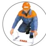
① Démarrer au point haut de la dalle. Ajuster le niveau des platines à l'aide d'un niveau laser et du niveau à bulle.
