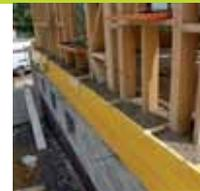
Mur banché en béton de chanvre
