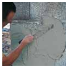
Réalisation d'un sous-enduit
