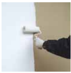
Application du PRB CRÉPIFOND G ou du PRB COLOR IMPER
