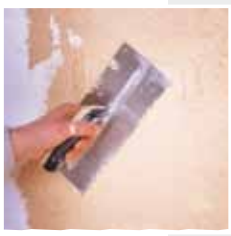
Application du PRB CRÉPIMUR au platoir inox
