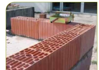
**1** - Réalisation du premier rang au mortier traditionnel hydrofugé (ép. 2 à 4 cm), à l'aide de platines. Attention, le premier rang doit être d'une planéité parfaite.
