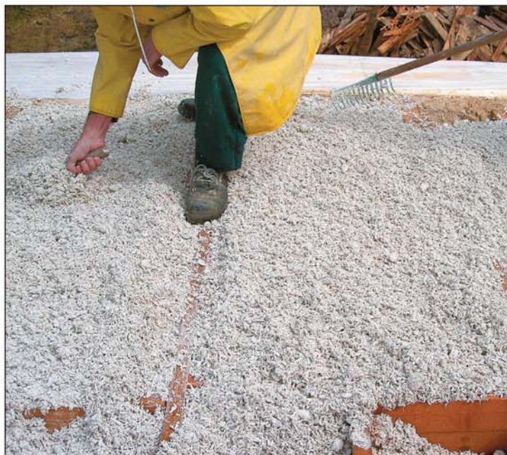
Le mortier est déversé en une fois entre les solives et soigneusement réparti
