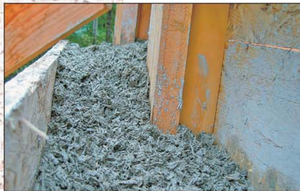
Vue du remplissage d'un mur banché
