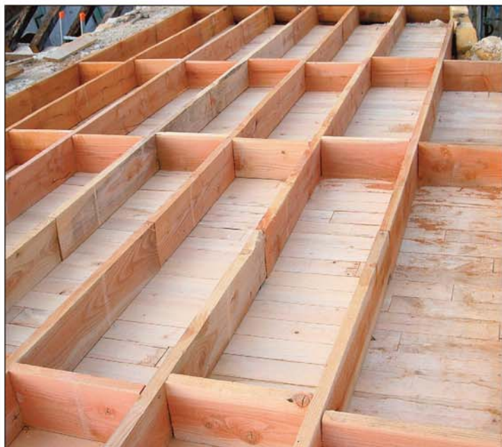
Vue d'un coffrage avant remplissage
