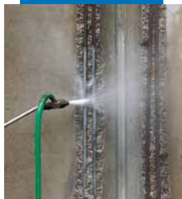
Décapage des fers par hydrosablage
