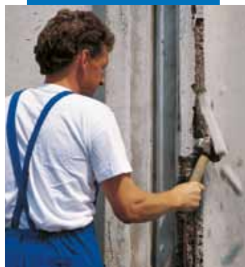
Démolition du béton dégradé
