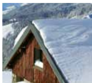
Bâtiment bien isolé
