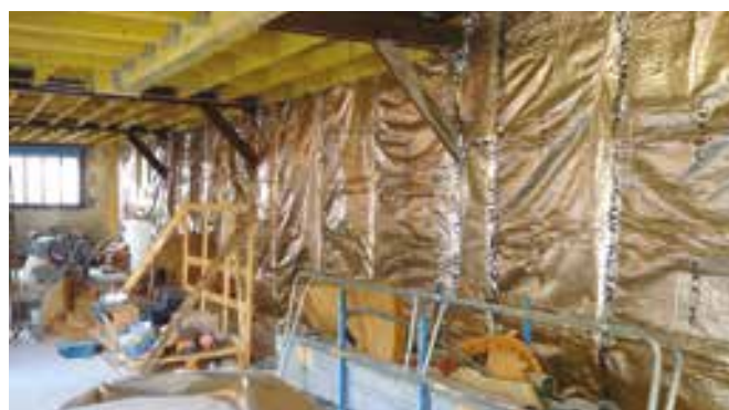
Rénovation d'une habitation à Paris (75)
