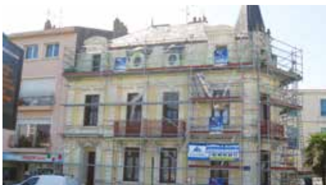
Rénovation d'un immeuble en Vendée (85)
