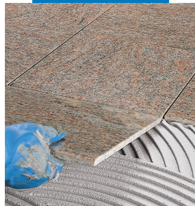
Pose de marbre poli en sol
