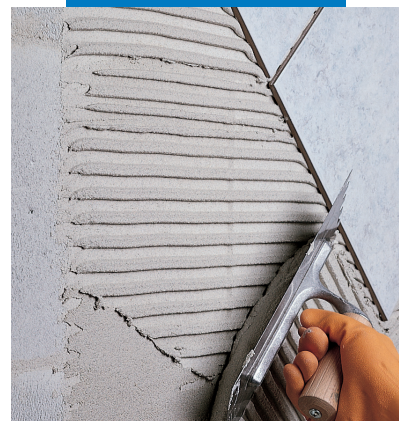
Pose de carreaux sur béton cellulaire
