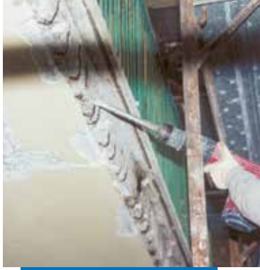
Réparation d'une allège de balcon: préparation du support
