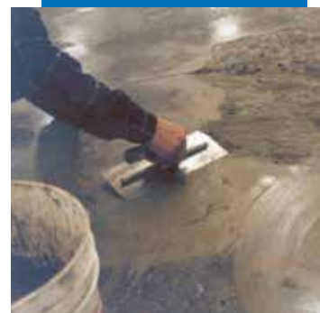
Réparation d'un sol industriel
