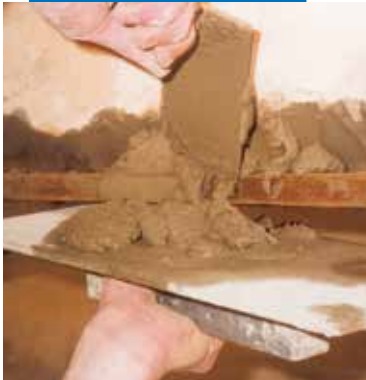
Réparation d'une allège de balcon : application du mortier
