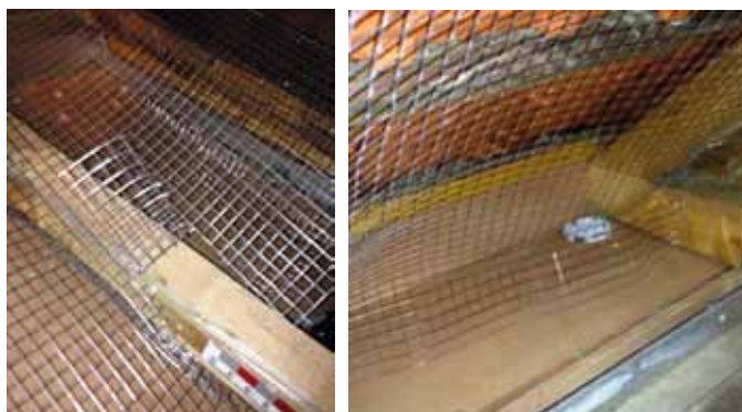
Figure 6 : Découpe et pliage du grillage en correspondance des entrainés (gauche) et maintien de l'aération (droite)
