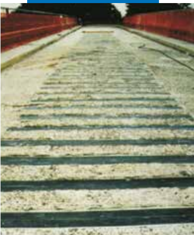
Travée béton renforcée avec les plats Carboplate
