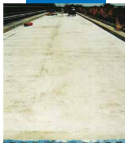
Travée béton reconstituée
