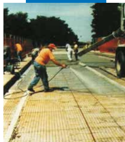
Application du primaire Epoxy
