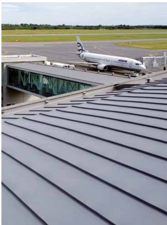
Aérogare, Brest - Architectes : Christian Weinmann & Denis Dietschy - Drlw architectes - Entreprise : Bihannic SA
