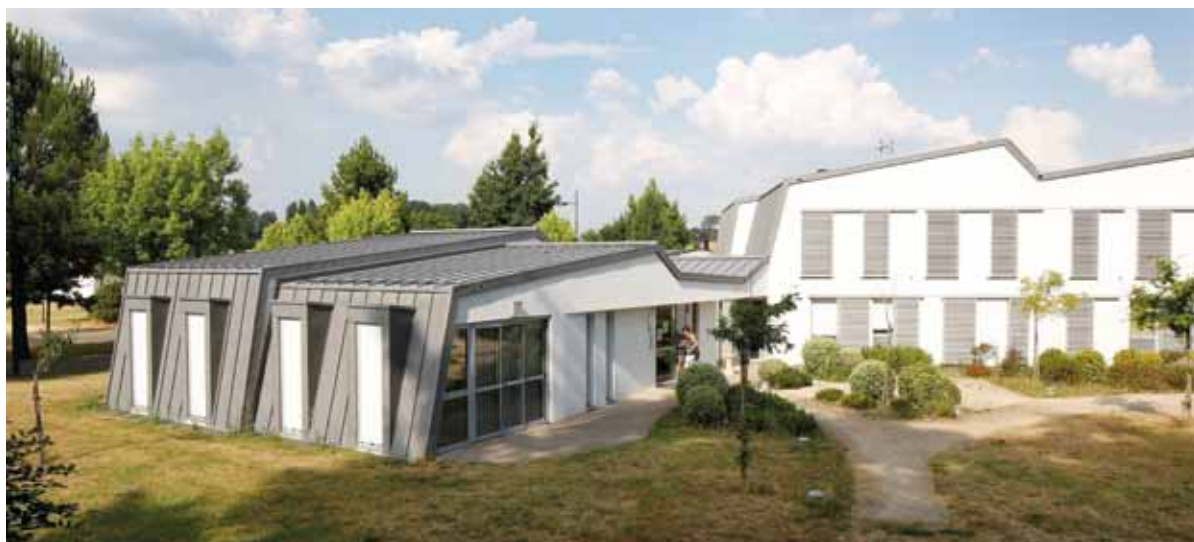
Foyer de jeunes travailleurs, Machecoul - Architecte : Atelier Pellegrino - Entreprise : Klein Couverture
