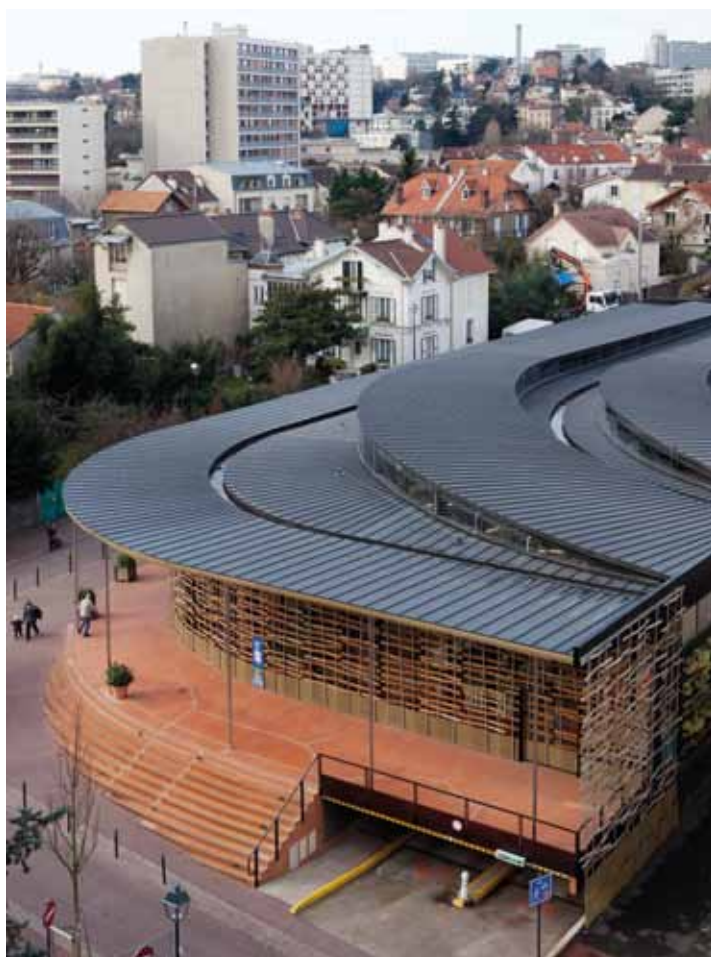
Halle de marché aux comestibles, Fontenay aux Roses - Architecte : Bertheliet & Tribouillet - Entreprise : BALAS
