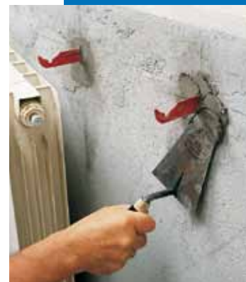
Fixation de supports pour radiateur avec Lampocem
