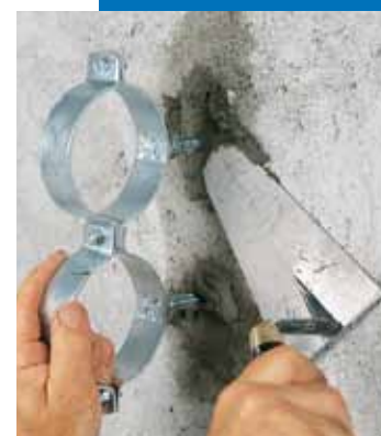
Fixation de colliers pour canalisation avec Lampocem
