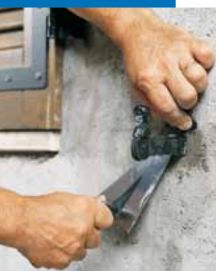
Fixation de gonds et d'arrêts de volets avec Lampocem
