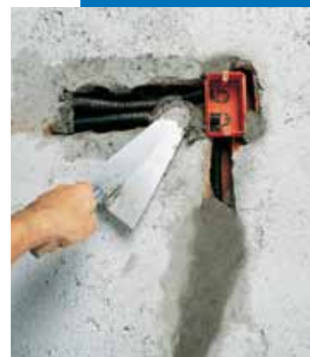
Fixation de boîtes et de fourreaux électriques avec Lampocem
