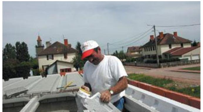
Gestion des travées démodulées en rive : des repères de découpe sont indiqués sur le rupteur transversal.
