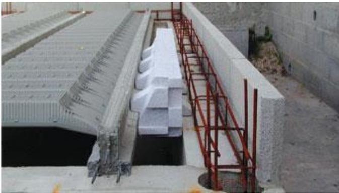
La première poutrelle doit être positionnée à 18 cm du bord du mur, de chaque côté de la construction.
