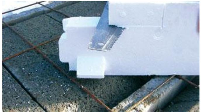
Penser à agrandir les encoches des premiers rupteurs longitudinaux aux angles de la construction (suivre pour cela les repères de découpe prévus à cet effet).
