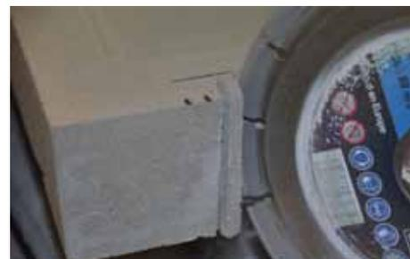
La coupe doit être faite en étant perpendiculaire à l'appui, celui-ci étant calé pour ne pas riper lors de l'opération.
