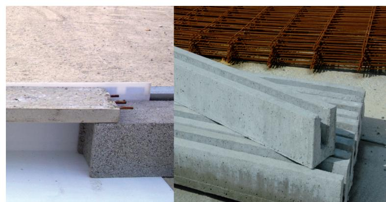
Ils sont soit « monoblocs », on utilise alors des poutres standards, soit « composites » : constitués d'un prélinteau complété par des blocs pleins ou du béton mis en œuvre sur chantier. Cette solution permet des gains de temps considérables à la mise en œuvre.
