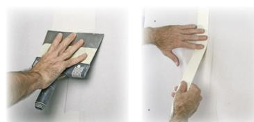
2. Appliquer la bande à joint papier sur l'enduit sur la longueur des plaques
