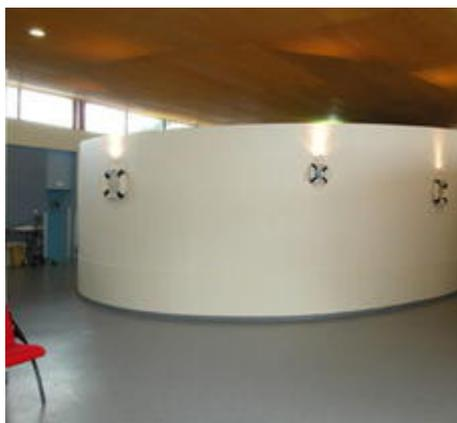
Plaque de plâtre d'épaisseur 6mm pour réalisation d'ouvrages courbes
